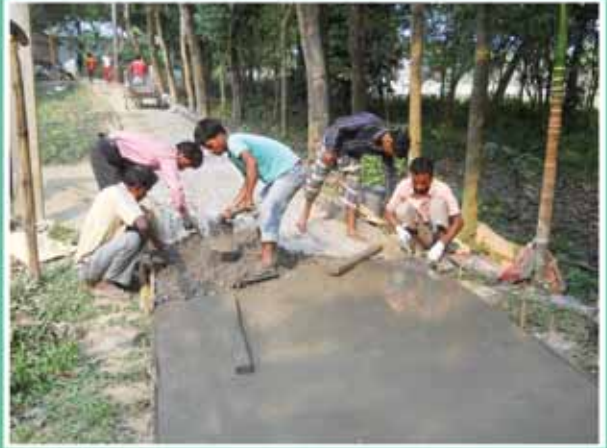
ভেরাভেরী মানাবাড়ি থেকে বাইশগুড়ি গ্রাম পর্যন্ত পাকা কংক্রিটের রাস্তা নির্মাণ চলছে।
