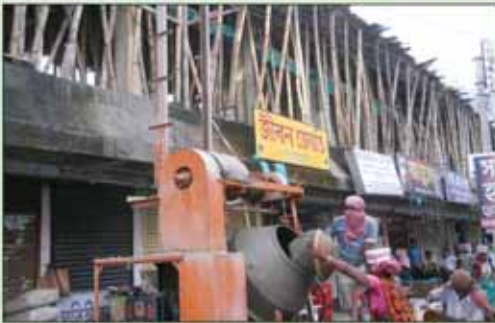
মাথাভাঙা চৌপাশীতে দ্বিতল মার্কেট কমপ্লেক্স নির্মাণের কাজ চলছে
