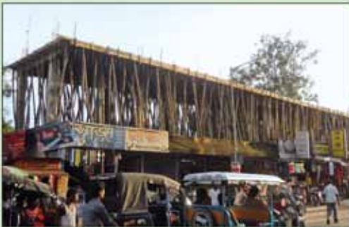
মাথাভাঙা ইমিগ্রেশন রোডে দ্বিতল মার্কেট কমপ্লেক্স নির্মাণ চলছে
