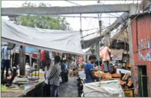
মাথাভাঙা মাছ বাজার পুনর্নির্মাণের কাজ চলছে
