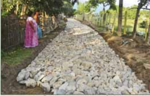
সুটঙ্গা ও মানসাই নদীর বাঁধ বরাবর পাকা রাস্তা নির্মাণের কাজ চলছে
