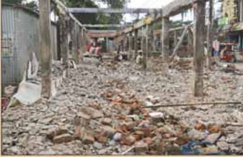
মাথাভাঙা মাছ বাজার পুনর্নির্মাণের কাজ চলছে
