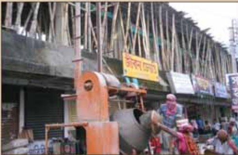
মাথাভাঙা চৌপাখীতে দ্বিতল মার্কেট কমপ্লেক্স নির্মাণের কাজ চলছে
