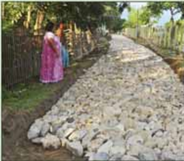
সুটঙ্গা ও মানসাই নদীর বাঁধ বরাবর পাকা রাস্তা নির্মাণ
