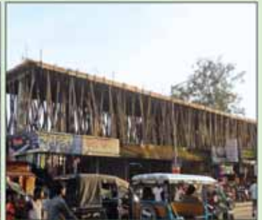
ইমিগ্রেশন রোডে দ্বিতল মার্কেট কমপ্লেক্স নির্মাণ
